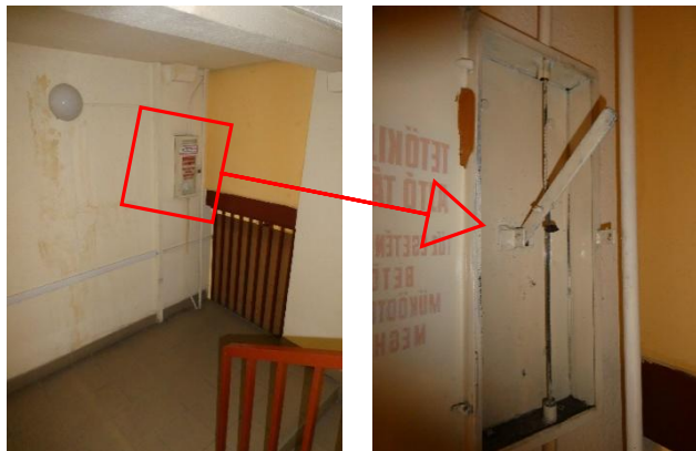
2. kép: Hő- és füstelvezetést, menekülést biztosító távnyitó
